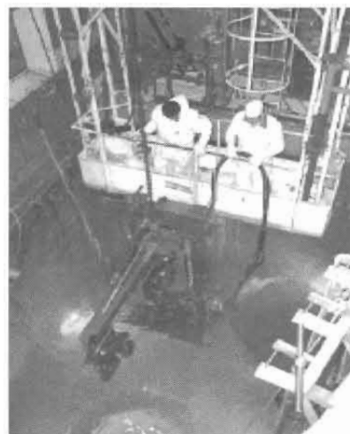
図1 炉内構造物及び原子炉圧力容器の切断に使用された機械的切断装置
